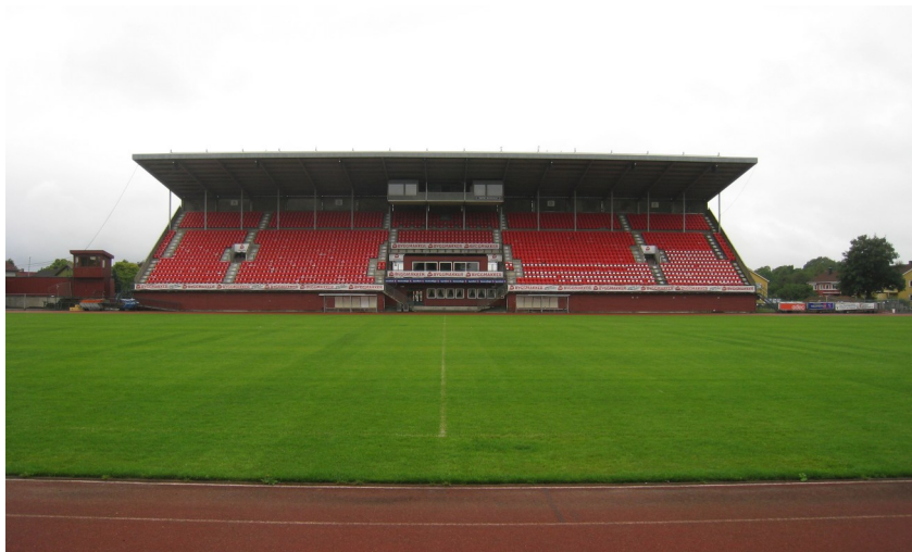
Melløs stadion etter installering av naturgresset
